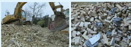
Collecte lors de la démolition
